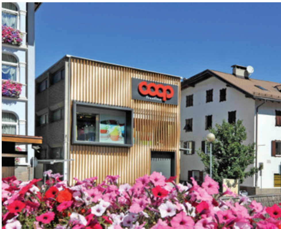
La nuova facciata del negozio, completamente ristrutturato, in Piaz de Sotegrava a Moena
